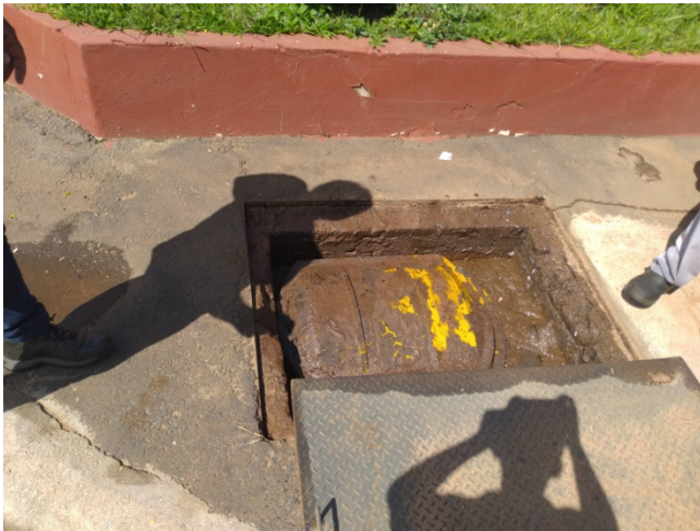
Fotografias 7 e 8: Caixa separadora de água e óleo (CSAO).
