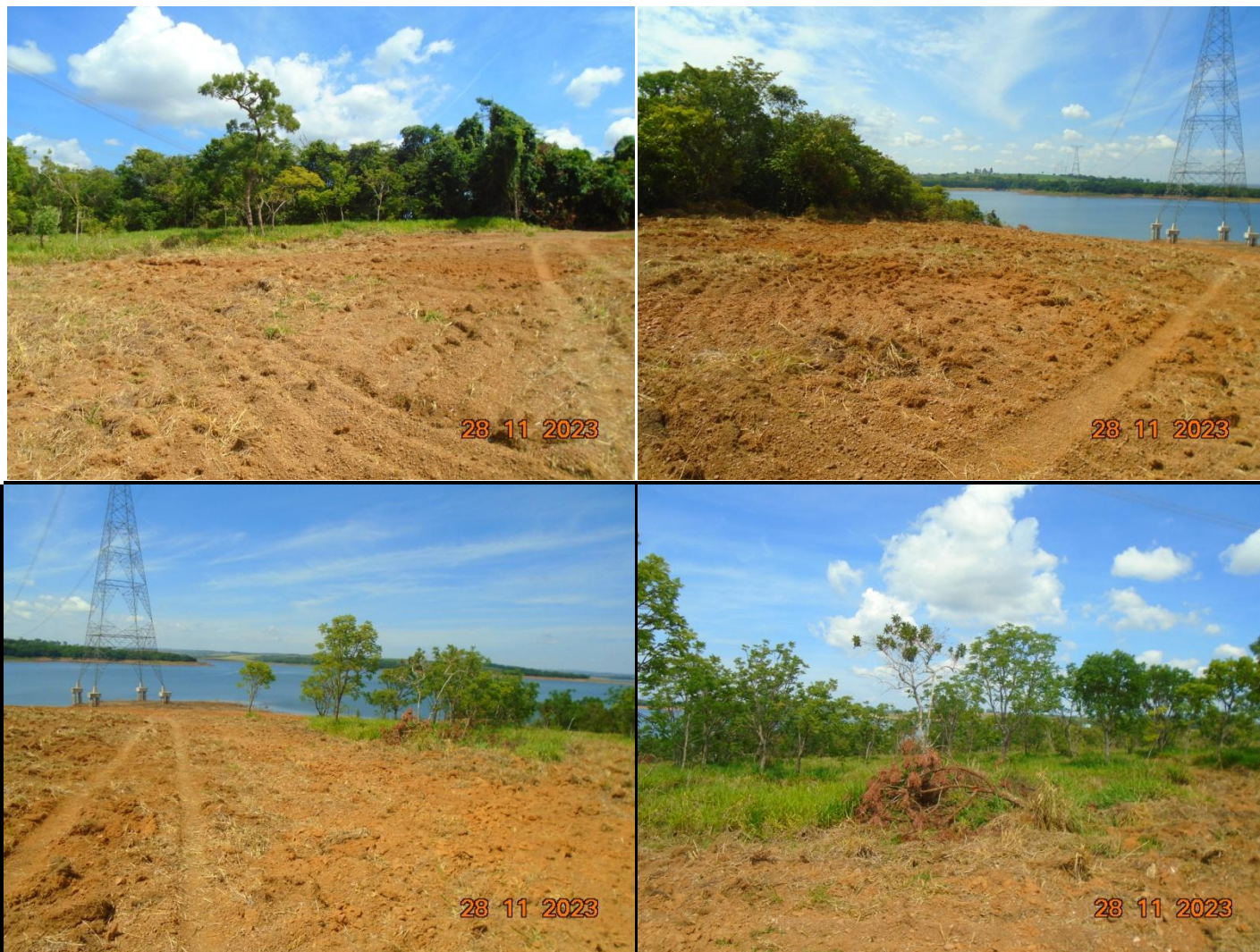
Figuras 01 a 04: Área para instalação das infraestruturas de apoio à aquicultura em tanque-rede e corte de árvores isoladas nativas vivas
