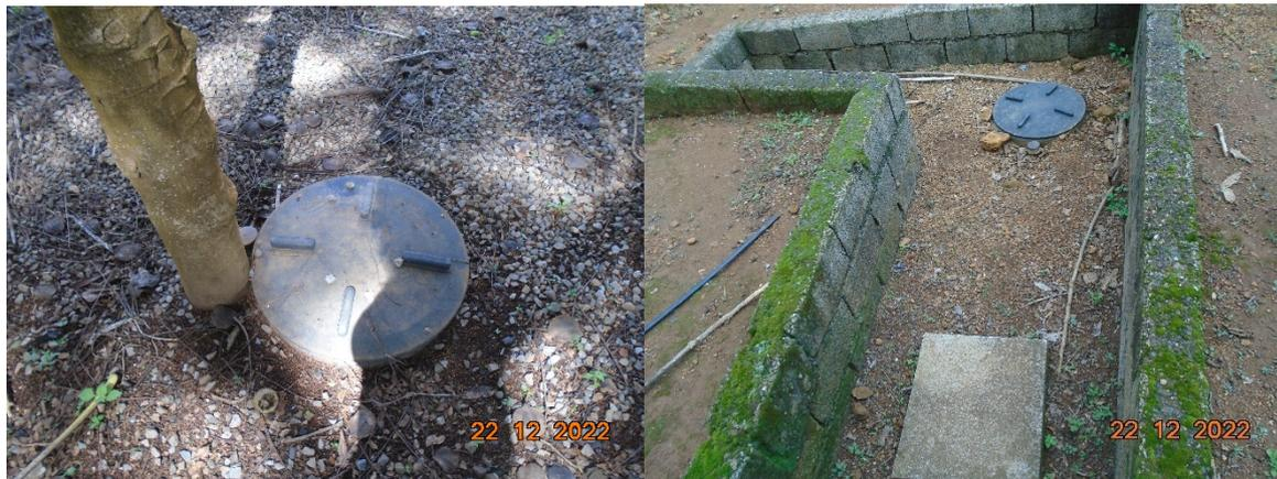
Fotos 03 e 04: Sistemas de tratamento de efluentes sanitários das residências – biodigestores.
