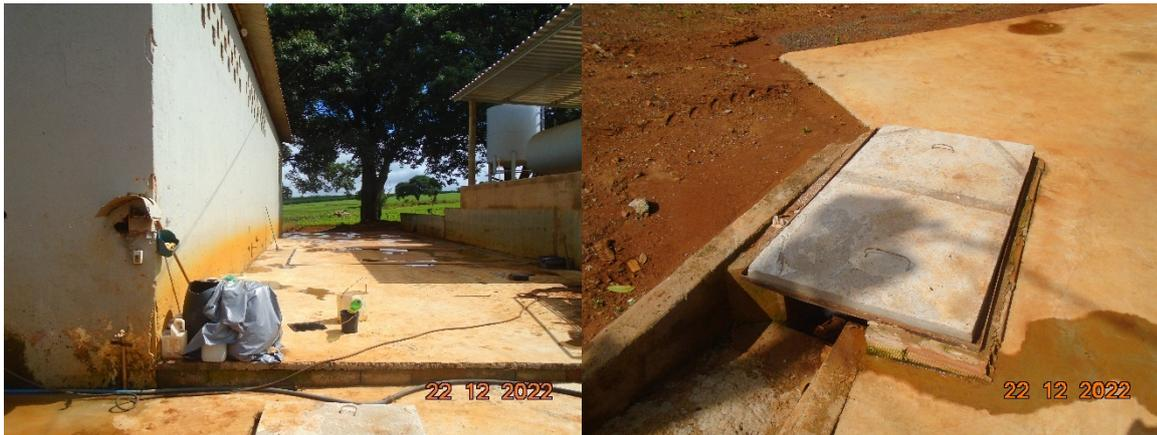
Fotos 09 e 10: Área impermeabilizada com drenagem para caixa SAO.
