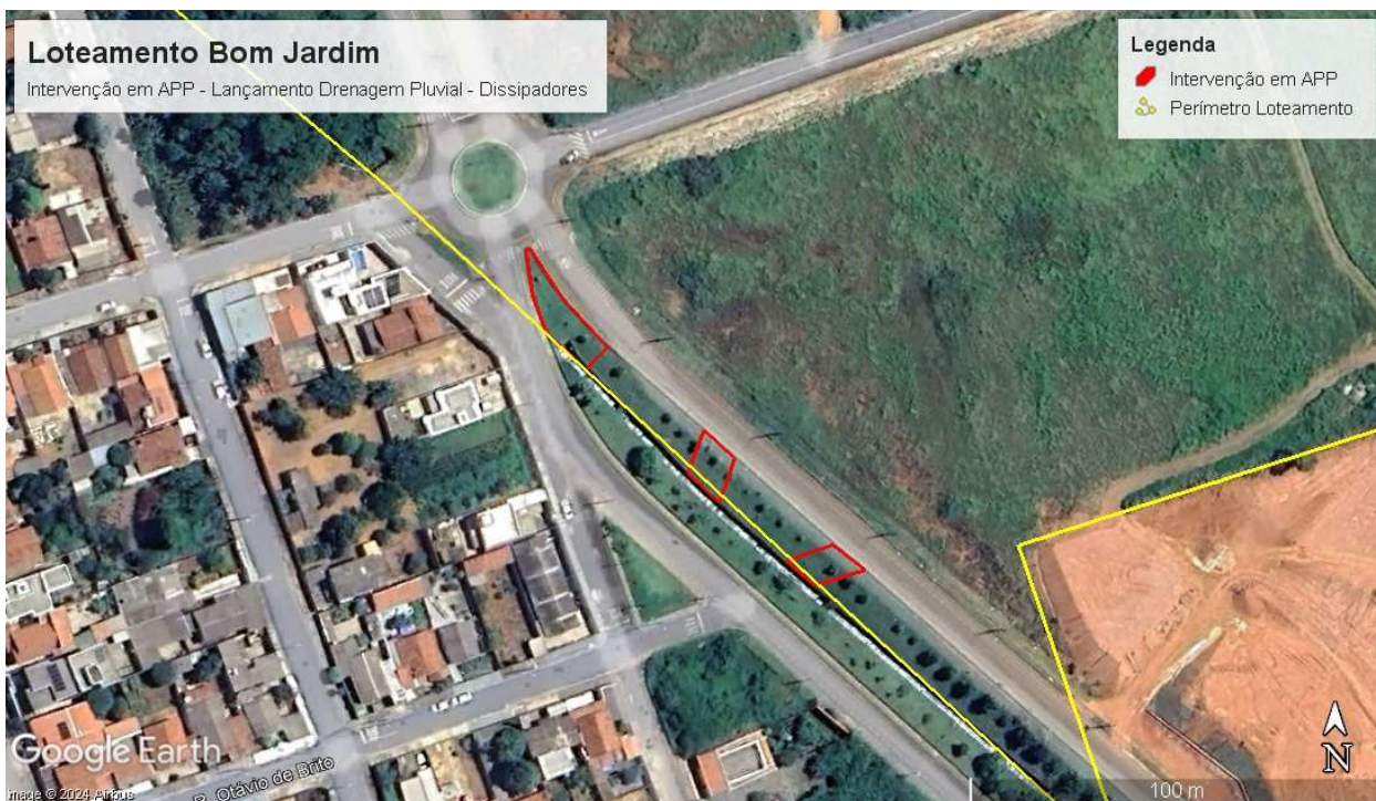
Foto 3: Imagem da consultora: os 3 pontos de dissipadores em APP "Córrego Av. Doutor Walter".
